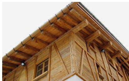
Retro-Holz lässt sich statisch mit C20 berechnen.
