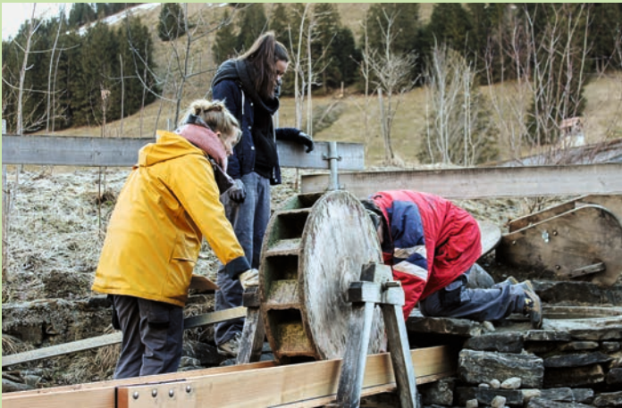
Auch die Wasserrad-anlage konnte repariert werden.
