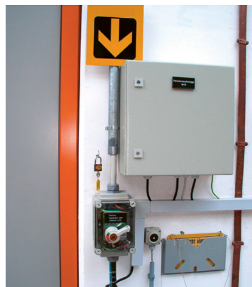
5 Interruttore generale della gru che può essere disinserito e messo in sicurezza contro l'avviamento accidentalmente con un lucchetto.
